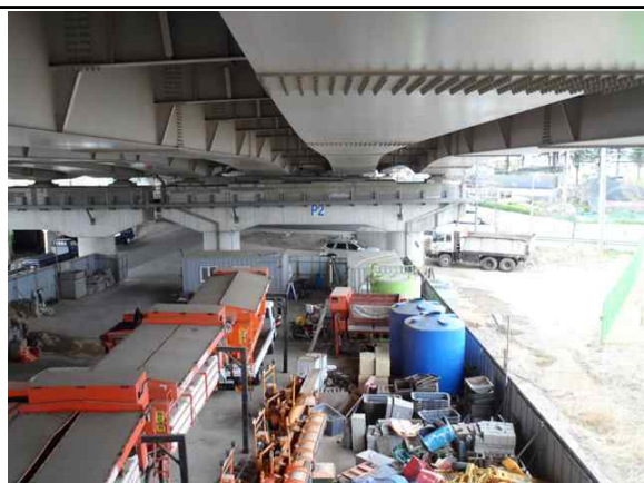
교각 P2 전경
