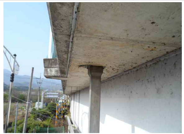
바닥판하면 캔틸레버부 전경(외측)
