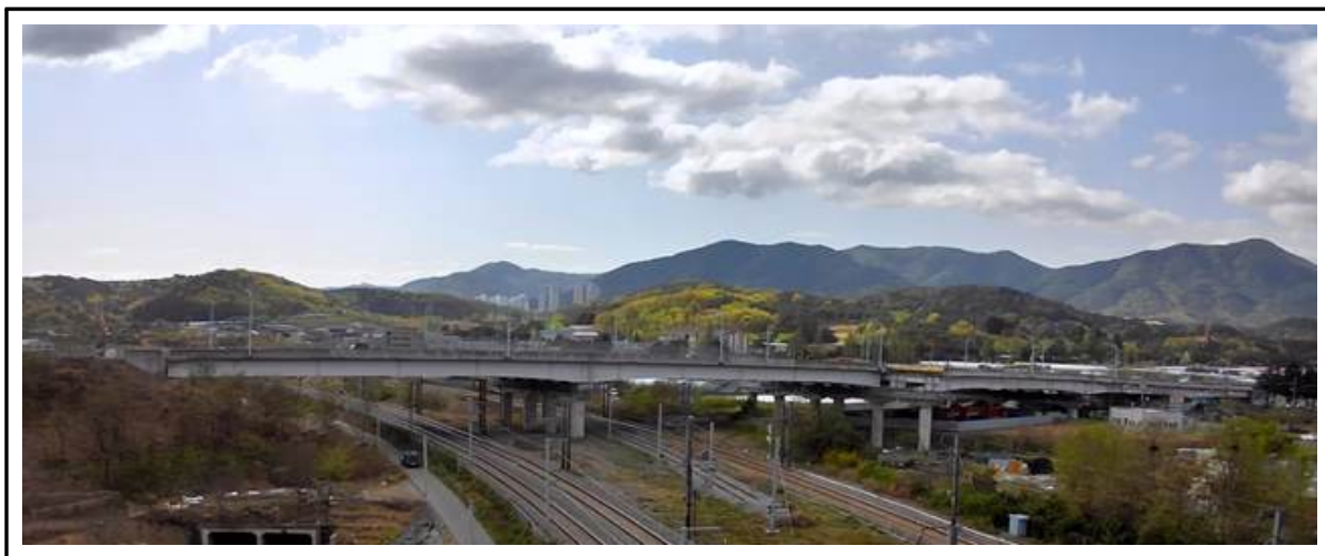
<그림 3.1> 가천교 측면 전경
