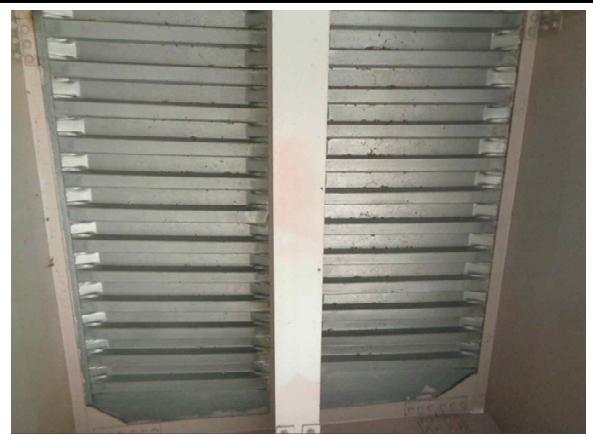
바닥판하면 데크플레이트 전경
