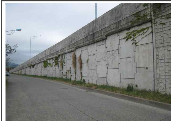
A1 날개벽측 판넬형옹벽 상태양호
