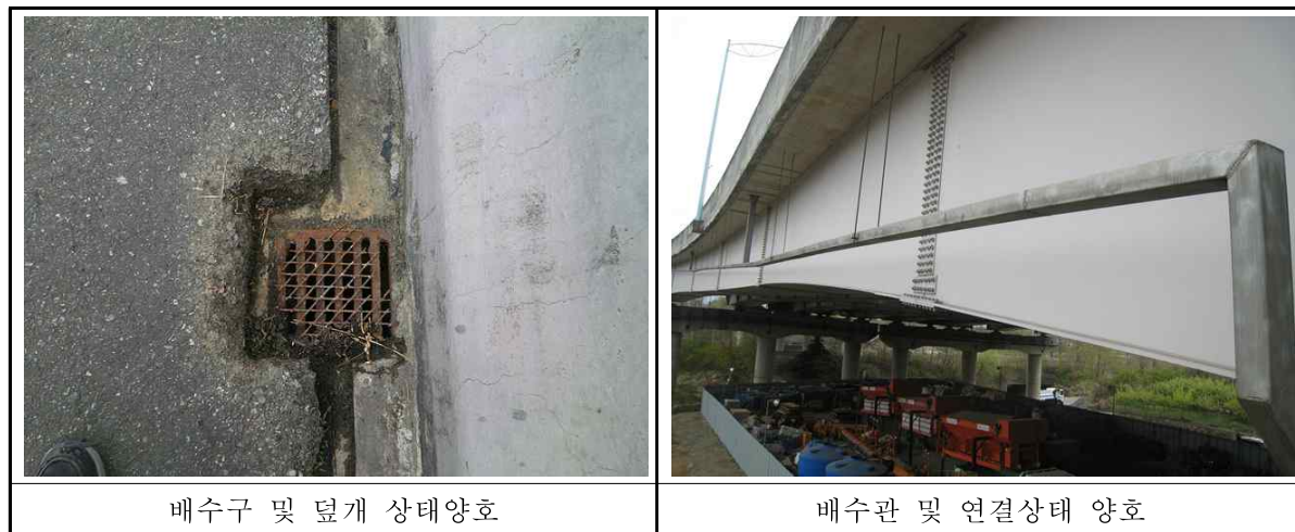
&lt;표 3.24&gt; 범물방향 배수시설 외관조사 결과
