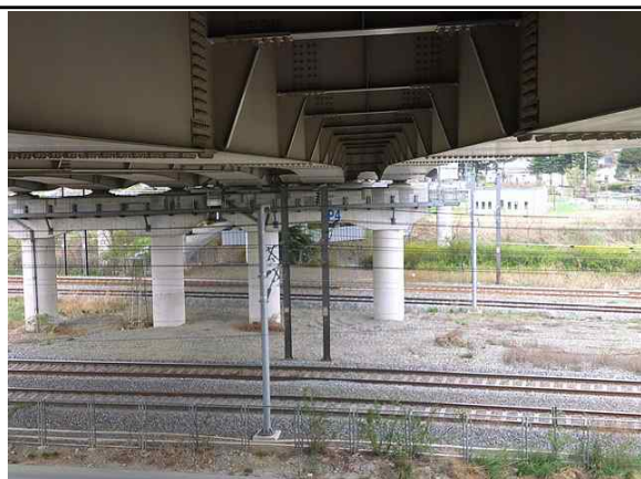
교각 P4 전경
