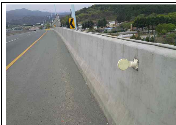
외측 방호벽 및 오물투척 방지망 전경
