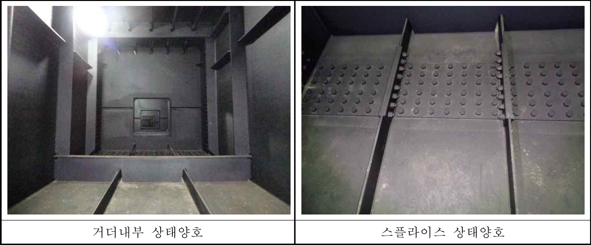
<표 3.33> 안심방향 거더 내부 외관조사 결과
