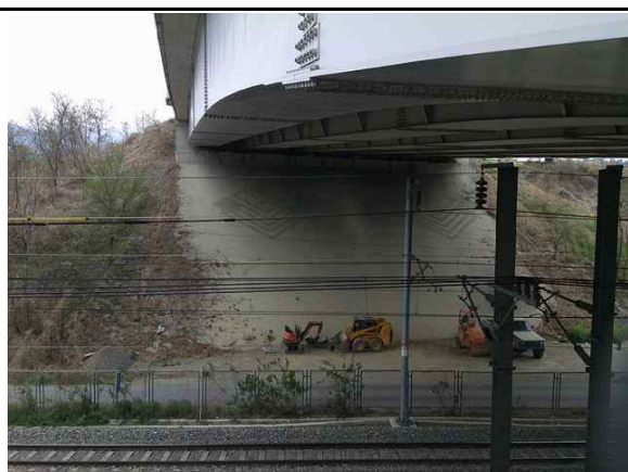
교대 A2 전경
