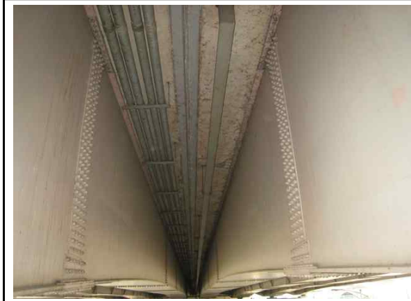
바닥판하면 캔틸레버부 전경(내측)
