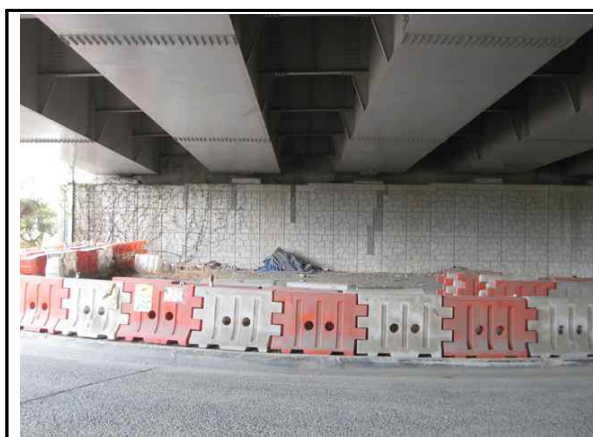
교대 A1 전경
