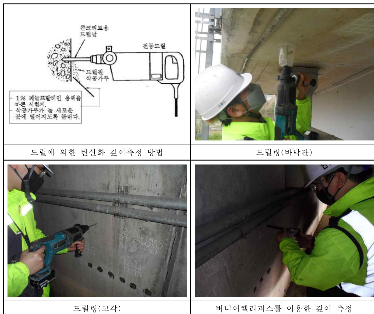
<그림 3.12> 드릴에 의한 탄산화 깊이 측정
