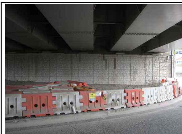
교대 A1 전경
