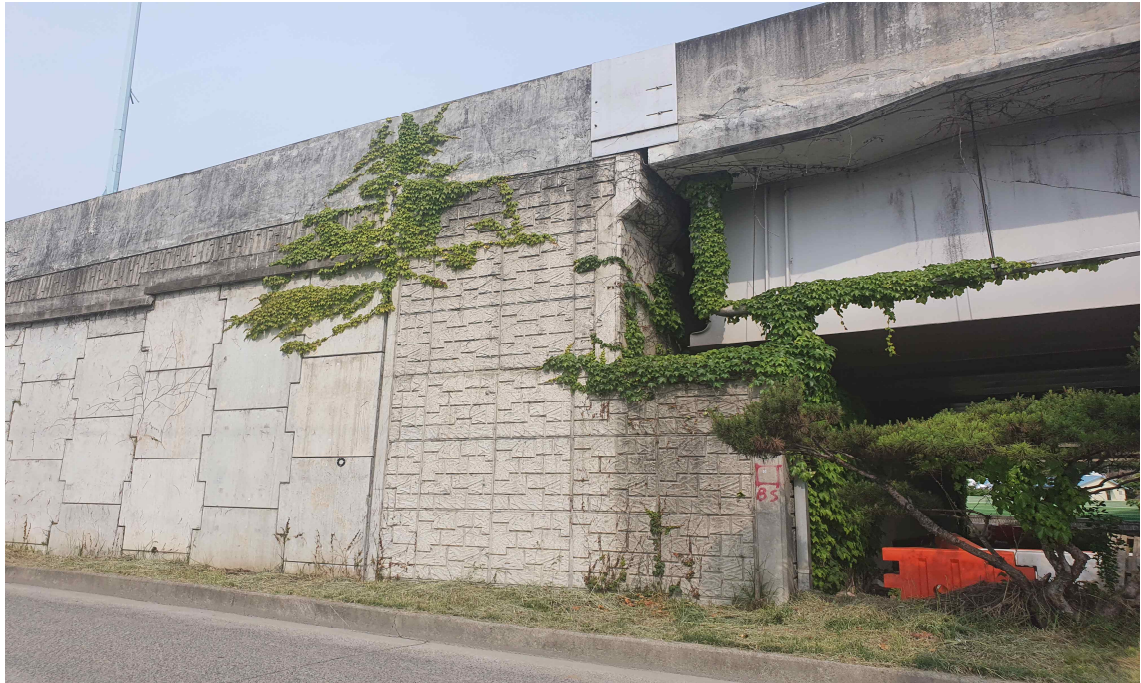
하부구조 전경 - 교대(A1)
