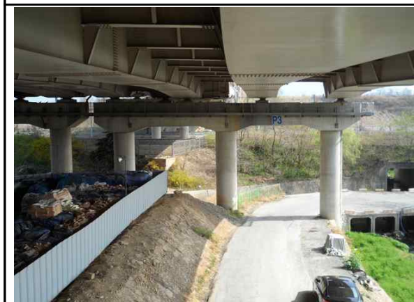
교각 P3 전경
