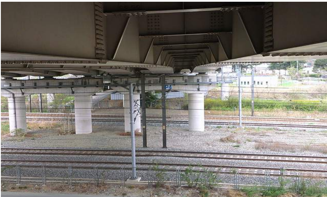
하부구조 전경 - 교각(P4)
