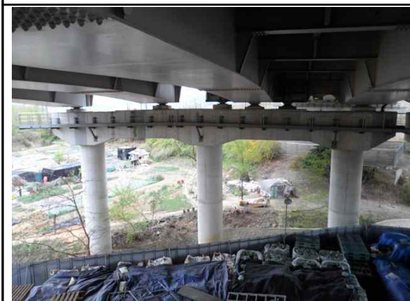
교각 P3 전경
